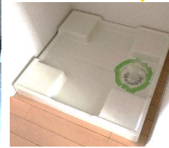
室内洗濯機置場
